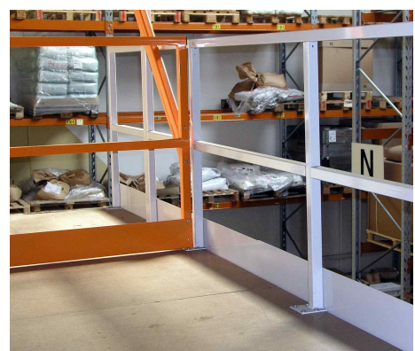
Platformgulv: spånplade Rækværk: pulverlakeret med fodplade
