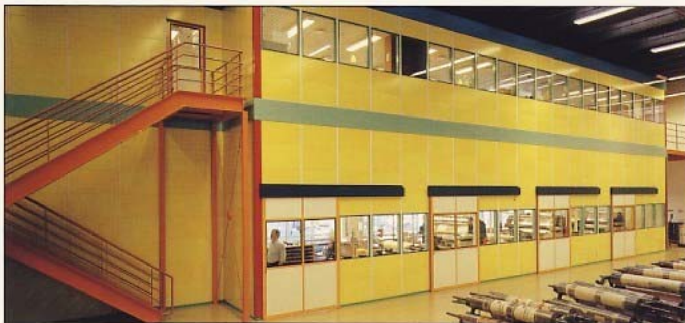
MATADOR-vægge, kontor og produktionslokaler
